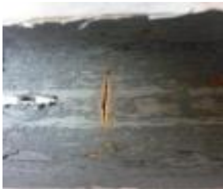
Gambar 4. 8 Material yang mengalami keretakan yang kemudian menjadi lubang
