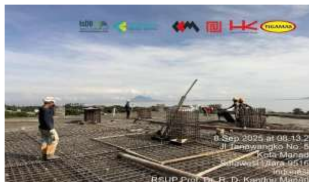
Gambar 8 : Pekerjaan pengecoran pelat lantai dan balok pekerjaan pemeliharaan
