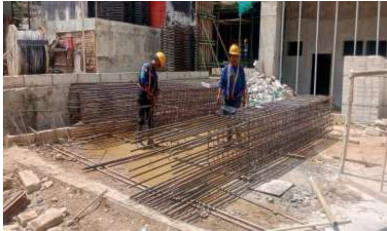
Gambar 1 : Pekerjaan Setrika Kolom
