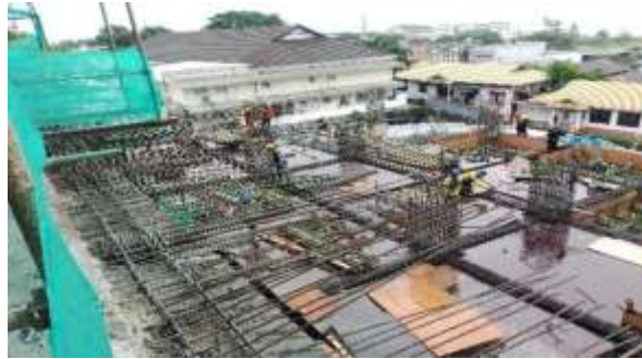
Gambar 4: Pekerjaan bekisting balok
