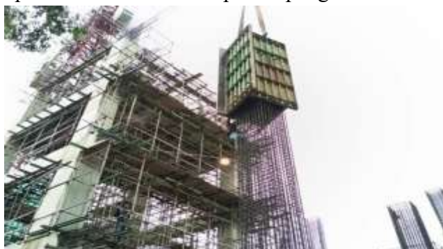
Gambar 2 : Bekisting Kolom
