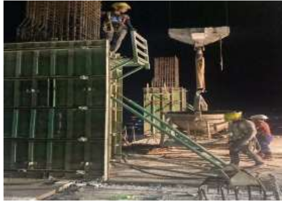
Gambar 3 : Pekerjaan Pengecoran Kolom
