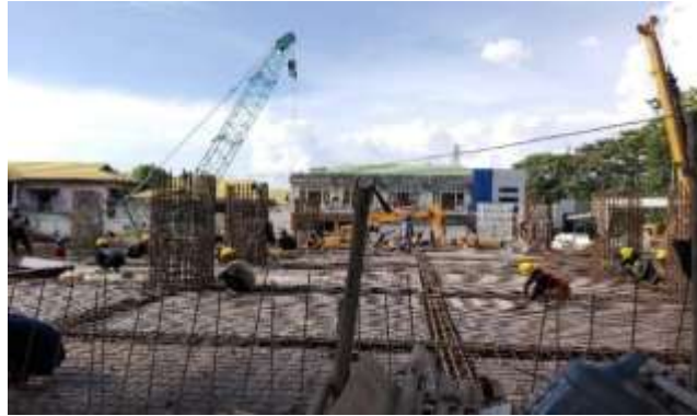
Gambar 7 : Pekerjaan Setrika Pelat Lantai
