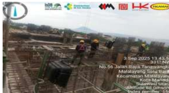
Gambar 5: Pekerjaan Setrika Balok
