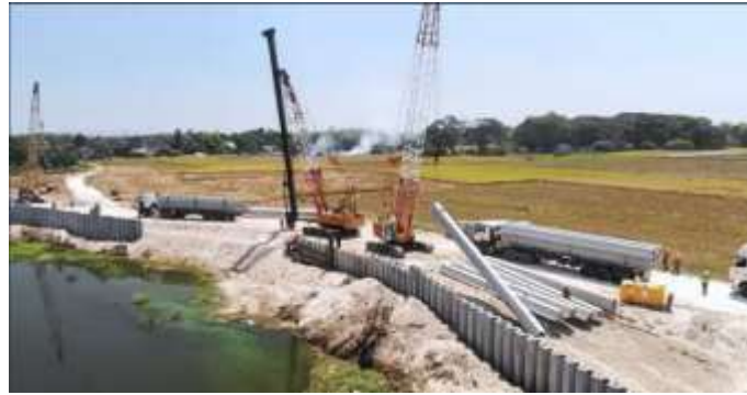
(a) Selama konstruksi
